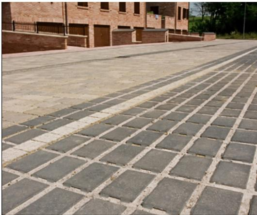
Figura 27: Una pavimentazione drenante (Fonte: Masulli).
