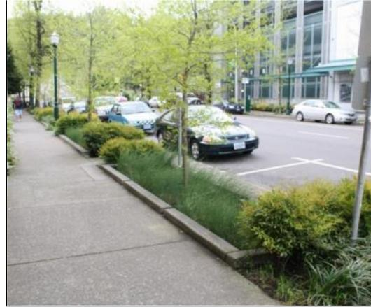
Figura 26: Un'aiuola d'infiltrazione (Fonte: EPA).
