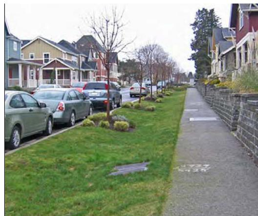
Figura 24: Un fossato d'infiltrazione (Fonte: EPA).
