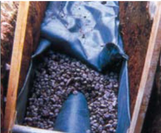
Figura 29: Una trincea d'infiltrazione (Fonte: EPA).
